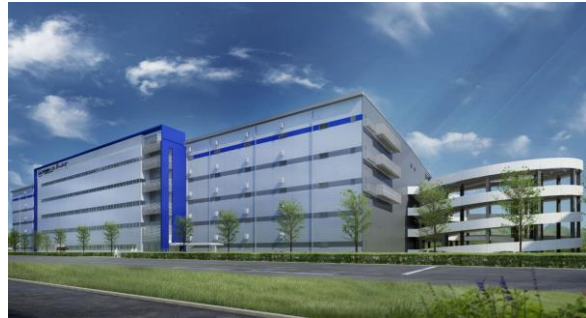
ダイナベース（京浜トラックターミナル） 平成30年7月竣工（予定）
