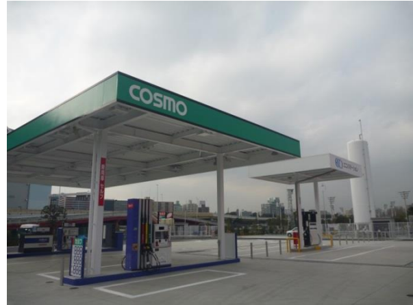
竣工した給油所
