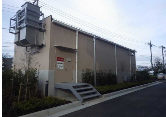
非常用自家発電設備を納めた建屋の外観
