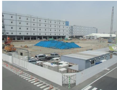
新7号棟建設工事エリア（京浜トラックターミナル）
